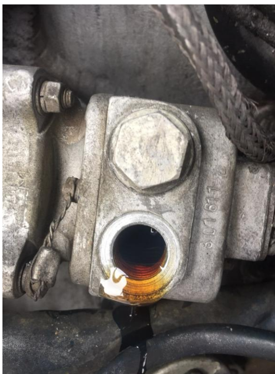
Фото 2. Полость концевых выключателей датчиков автоматического флюгирования ДАФ СУ № 3
